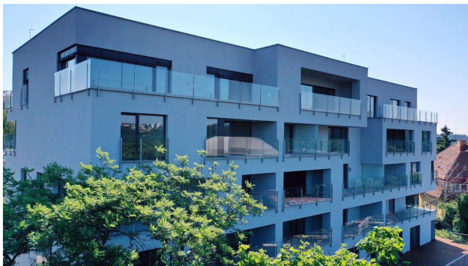
Obrázek 1 Fotografie realizovaného projektu „Novostavba domu Hippokrates“.
